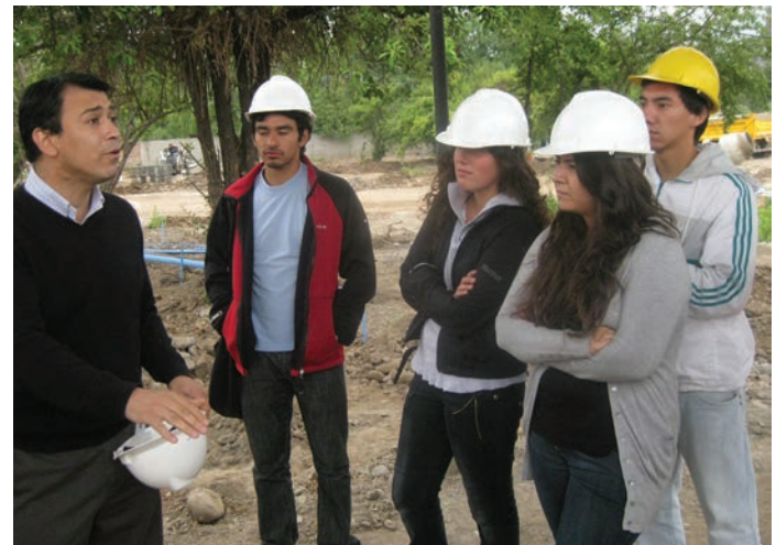
Explicación de los trabajos en la nueva piscina municipal de Puente Alto
