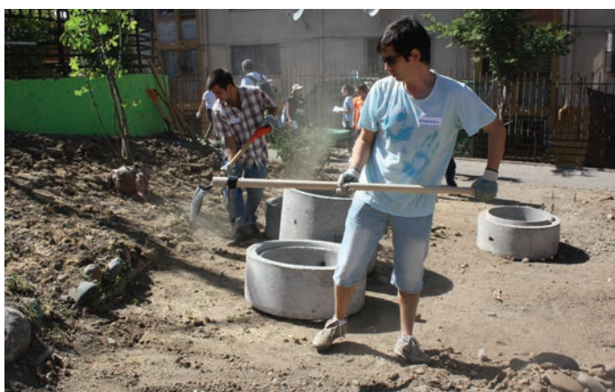
Trabajo de restauración de una plaza en Puente Alto
